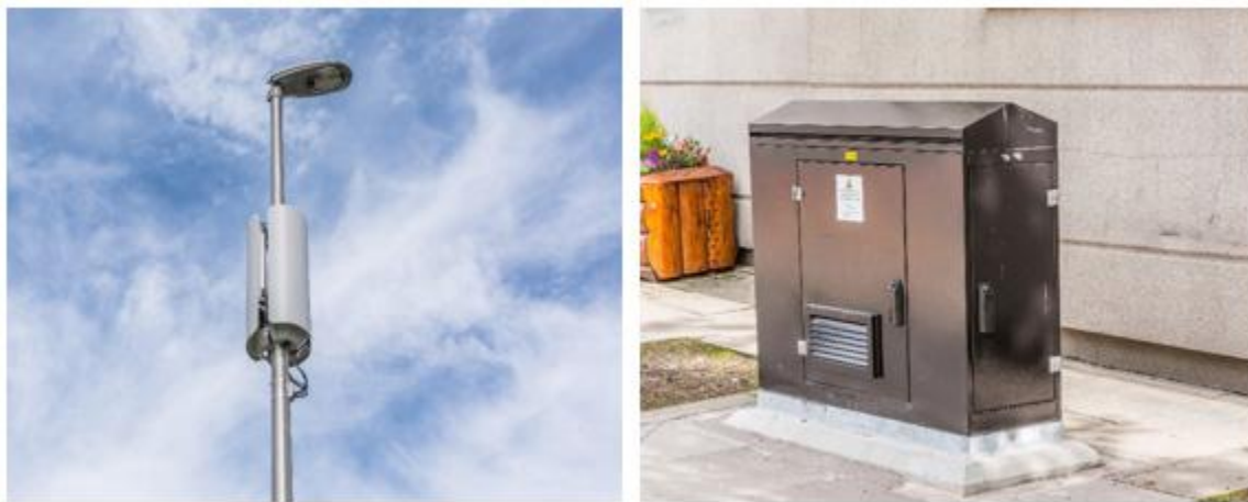
2.5-сурет – Шам бағанасына орнатылған антенна жүйесі және соған сәйкес сыртқы шкаф көрсетілген.
